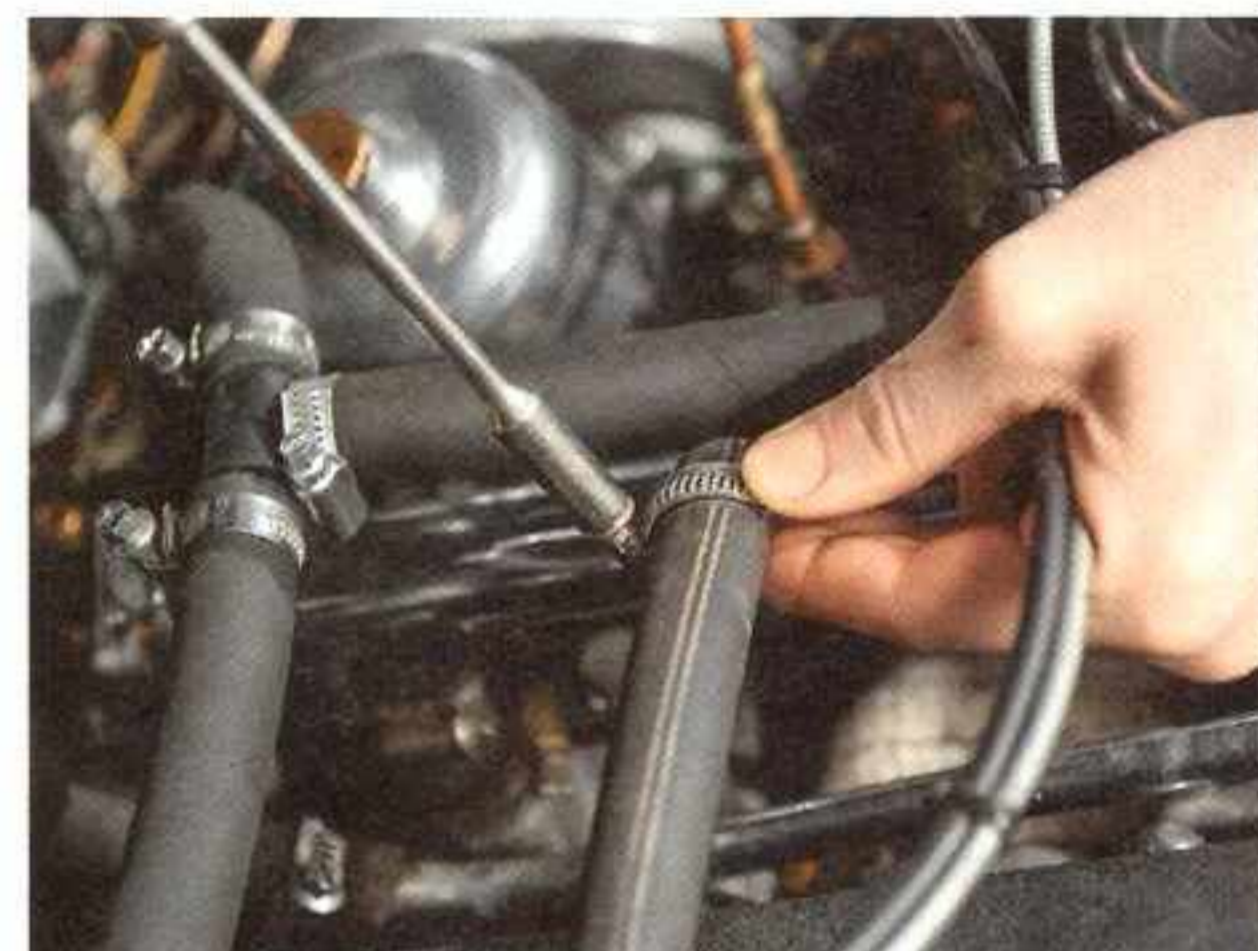
Die Anschlüsse müssen zwingend dicht sein, der Schlauch unterdruckgeeignet
